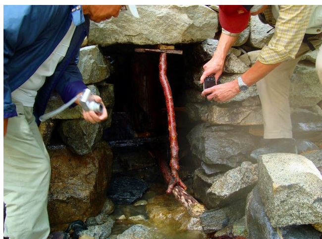
水の出口(水を止めた状態)、隙間調整棒(茶色)
