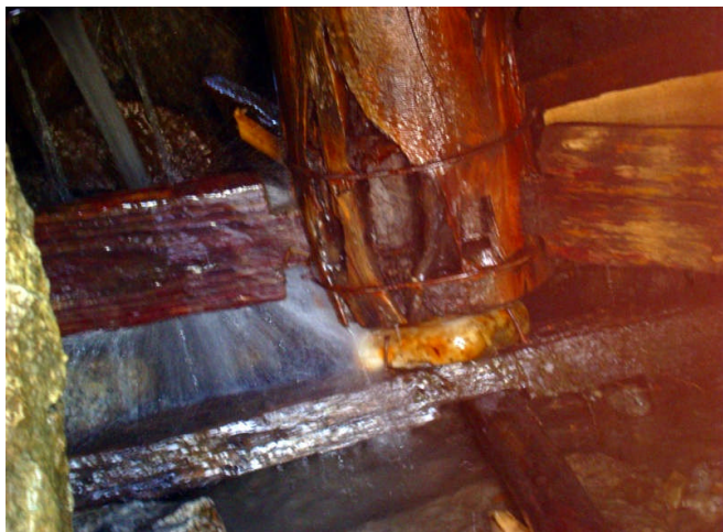
水車の羽根部分
