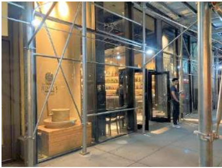
外観（ビル工事中）
